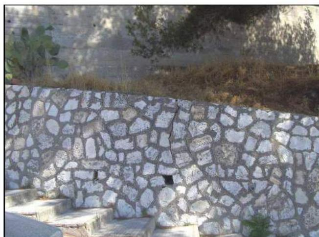
Foto n. 7 – Lesioni recenti che si sono manifestate lungo i muri di contenimento della S.P. all'interno dell'area 063-1CR-007
