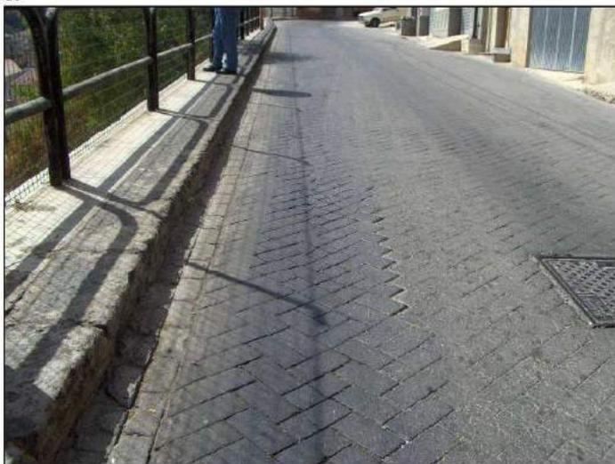
Foto n. 8 – Deformazioni della sede stradale lungo la via San Giuseppe all'interno dell'area 063-1CR-009
