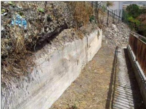
Foto n. 10 - Particolare di un muro di contenimento lesionato e parzialmente rotato a valle della via San Giuseppe.
